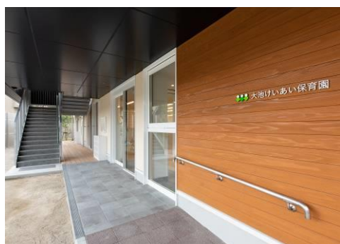
玄関～2 階への階段、テラス
